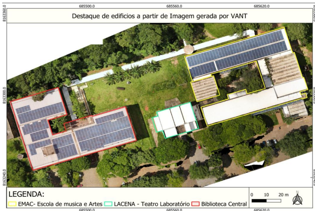
Figura 41 – Edifícios da Biblioteca Central, do Lacena e da Emac
