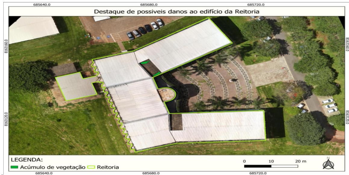
Figura 47 – Recortes do telhado da Reitoria da UFG com destaques de resíduos na cor verde
