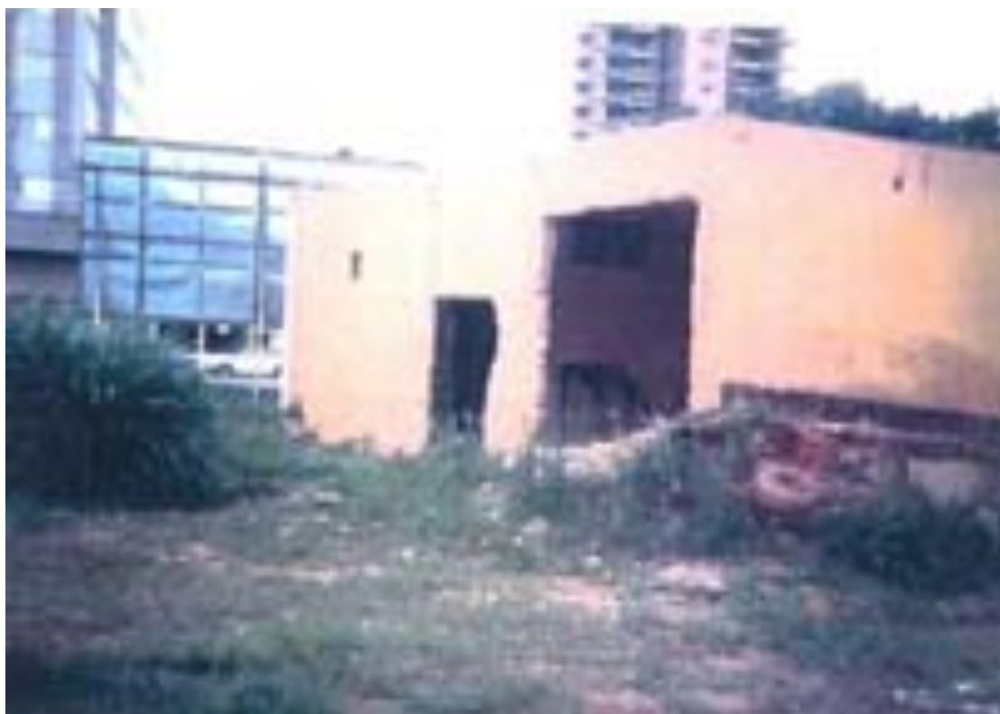
Figura 1 - Escombros do Instituto Goiano de Radioterapia
