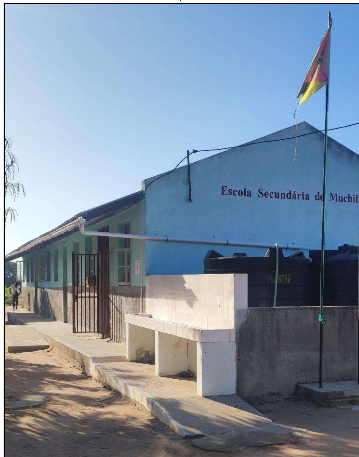
Figura 02: fachada central da escola, Bloco Administrativo e salas de aulas
