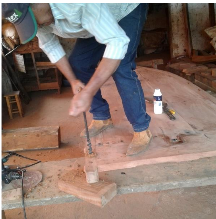
FOTOGRAFIA 46 - O carapina fura os buracos nos quais passarão os canzis
