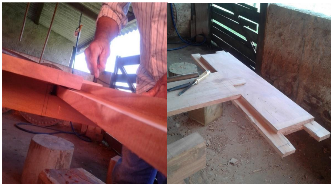
FOTOGRAFIA 39 - O recavem devidamente modulado e encaixado
