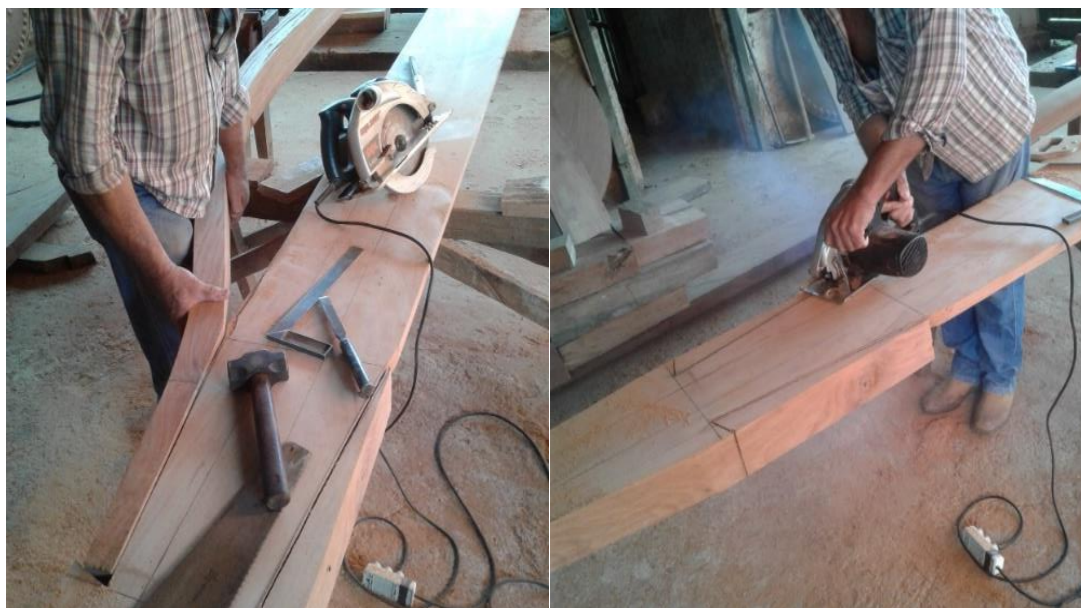
FOTOGRAFIA 34 - Serragem e modulagem do encaixe dianteiro das chêdas
