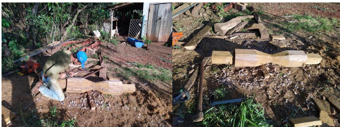
FOTOGRAFIA 53 - Eixo quase finalizado
