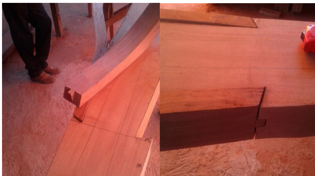
FOTOGRAFIA 35 - Encaixe da ponta das chêdas no cabeçalho em uma ‘amarração’
