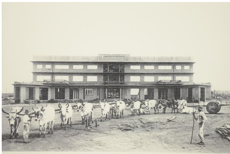
FIGURA 11 - Construção do Palácio do Governo
