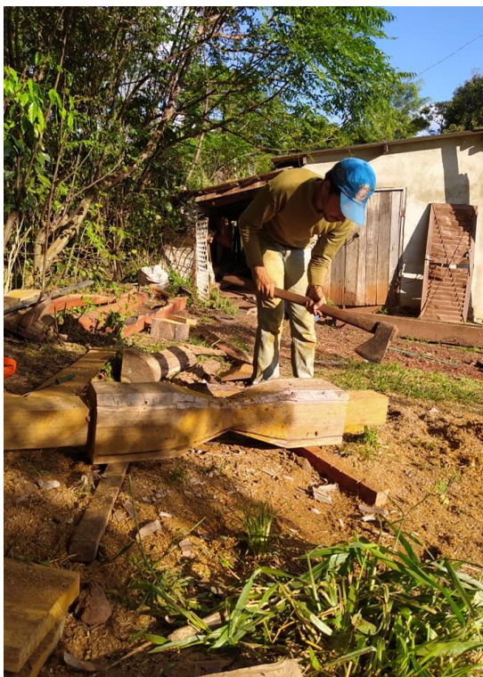
FOTOGRAFIA 52 - O machado substitui a serra para ‘oitavar o eixo’
