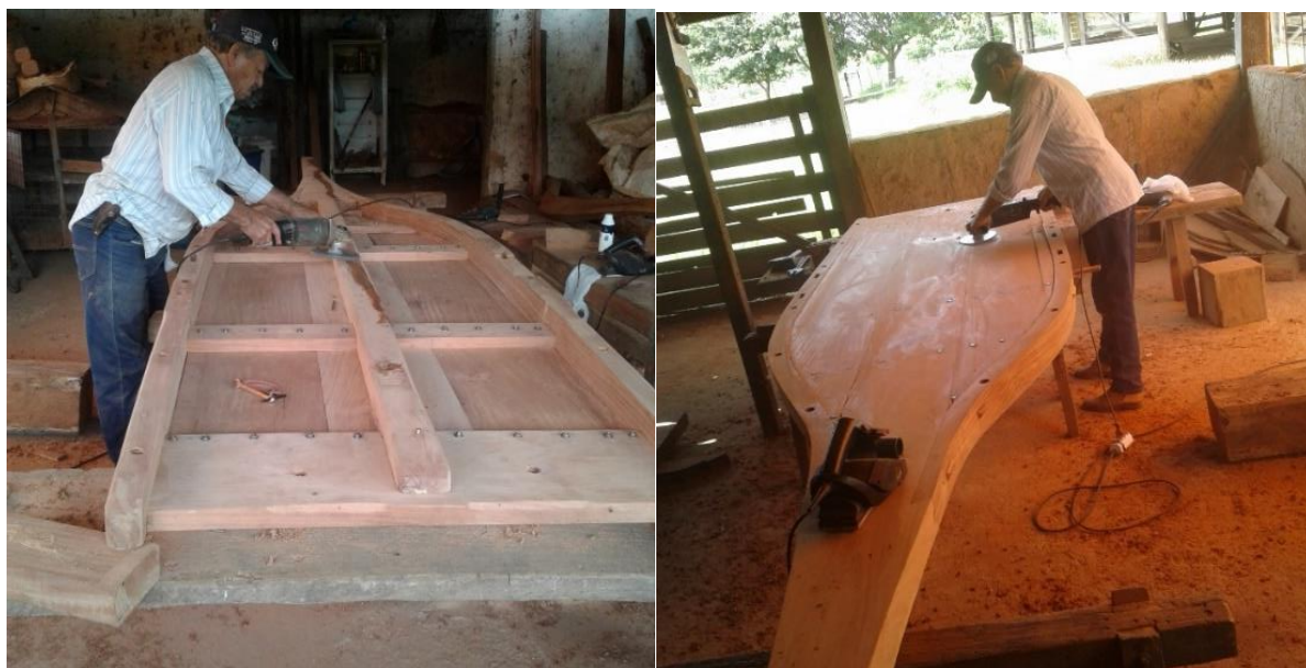
FOTOGRAFIA 45 - Modelando a parte de baixo e de cima da mesa
