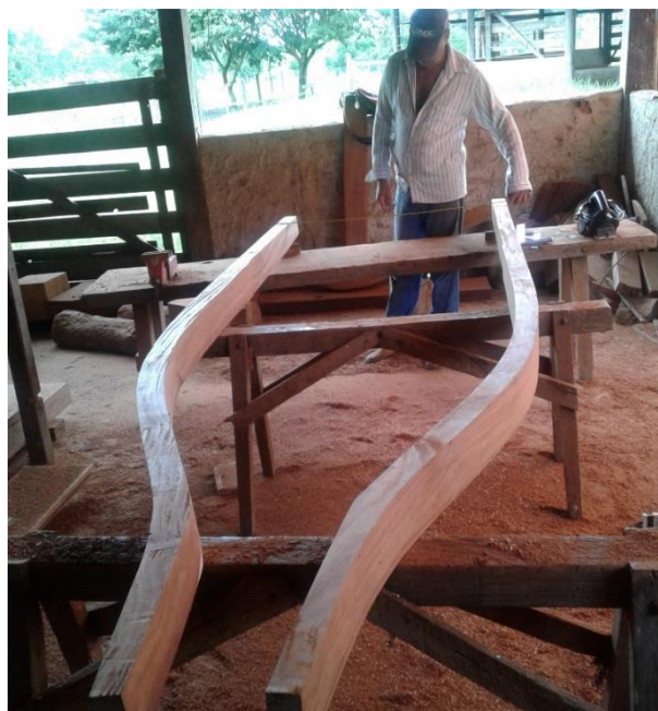
FOTOGRAFIA 33 - As chêdas formatadas em suas respectivas curvaturas
