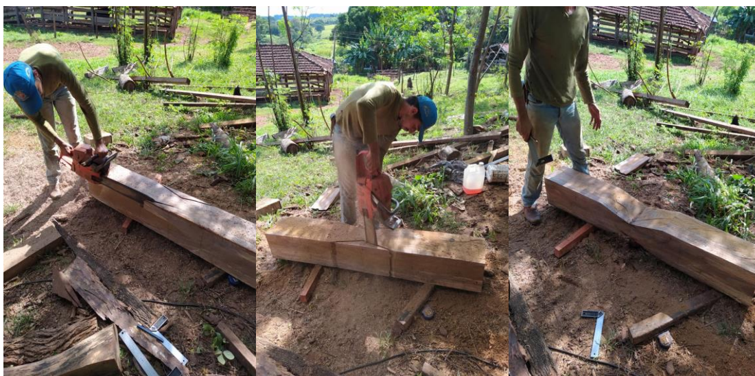
FOTOGRAFIA 50 - O carapina procede serrando e nesta sequência faz a ‘degola’ do eixo em sua parte central
