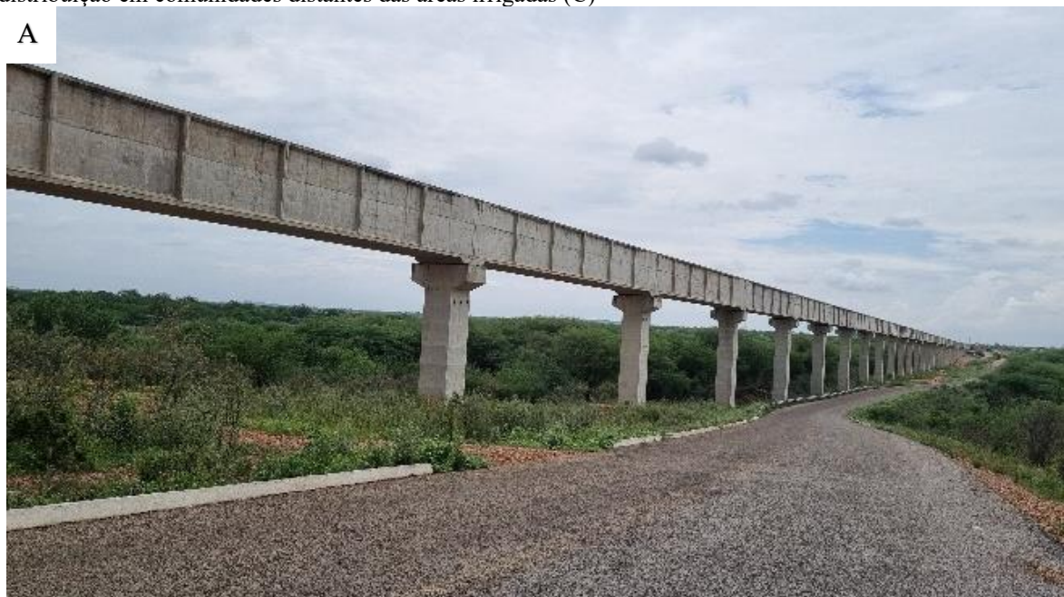
Figura 4 - Canais de transporte de água para os projetos irrigados na bacia hidrográfica do Riacho Pontal: Canal de transporte de água suspenso/Aéreo (A); Canal de transporte de água terrestre (B) e Captação de água para distribuição em comunidades distantes das áreas irrigadas (C)
