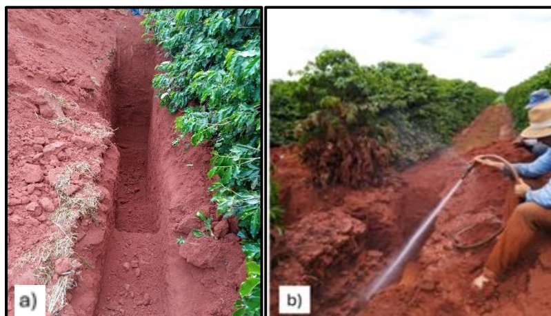
Figura 19. (a) Abertura da trincheira para derrubada das árvores de cafés, (b) Processo de lavagem inicial. Fonte: Próprio autor (2021).
