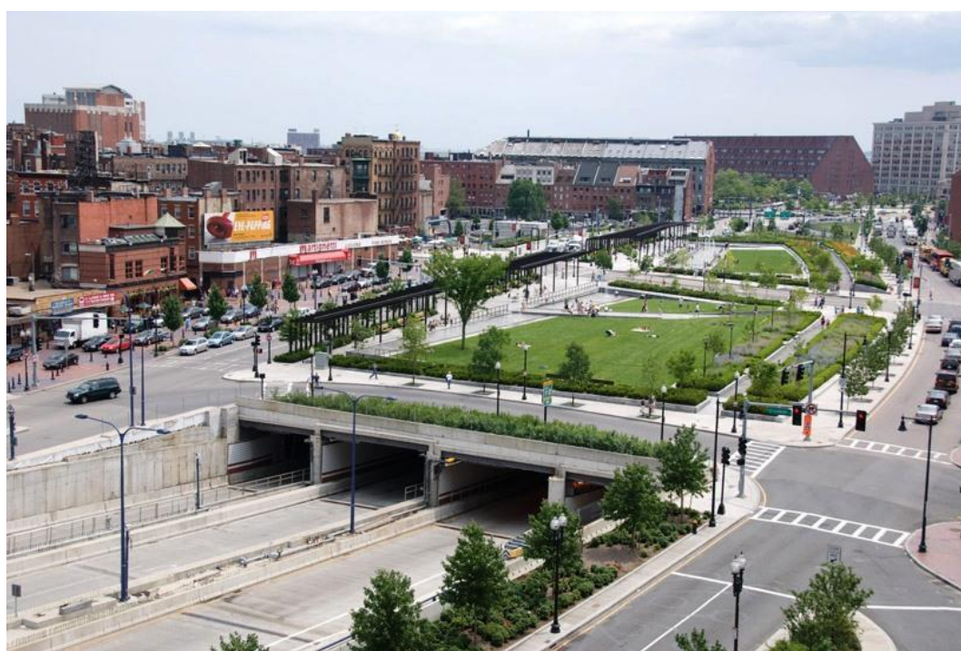
Figura 46. Enterrio de via expressa urbana em Boston, Estados Unidos. Fonte: Höweler - Yoon Architecture. Disponível em: http://www.designboom.com/architecture/audi-urban-future-award2012/ . Acesso em: 12 dez 2013.
