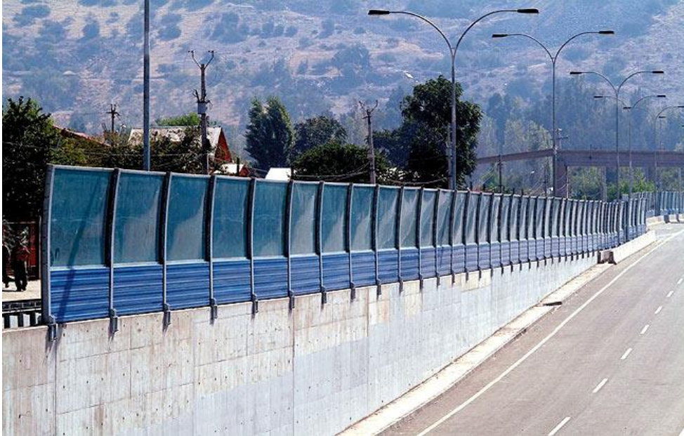
Figura 9. Barreira acústica em aço e acrílico. Disponível em: http://www.indac.org.br/imagens/barreiras_acusticas04.jpg/ . Acesso em: 7 nov 2013.
