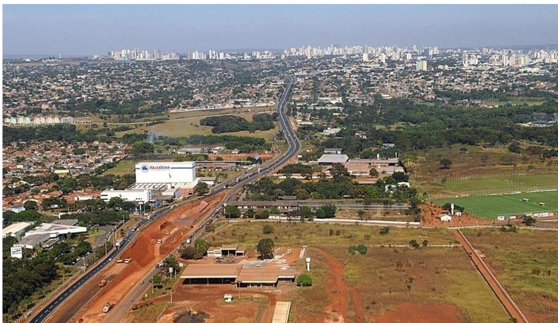
Figura 2. Vista aérea da BR-153 e sua inserção na área urbanizada de Goiânia. Foto: Antônio Pugás, 26 maio 2010. Fonte: arquivo pessoal.
