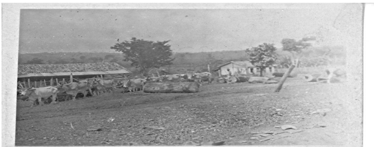
Figura 29: Carros de boi em "carretão" (sic) puxando tronco para a construção de Goiânia, possivelmente, na década de 1930. Fonte: AHE.
