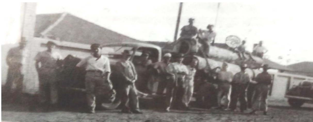
Figura 30: Caminhão carregando o que seriam “manilhas”, em Goiânia, para a construção da cidade. Data aproximada do final da década de 1930 e início de 1940. Mas também, poderia ser utilizado no transporte de toras de madeiras, assim como serragens e carvão, que podem ser considerados como “resíduos sólidos”. Fonte: Instituto Cultural e Educacional Bariani Hortêncio - ICEBO.
