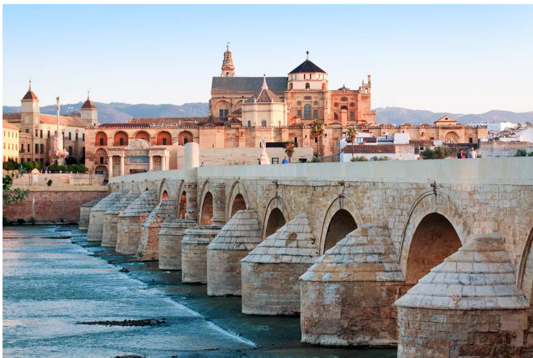
Figura 2 - Ponte Romana de Córdoba
