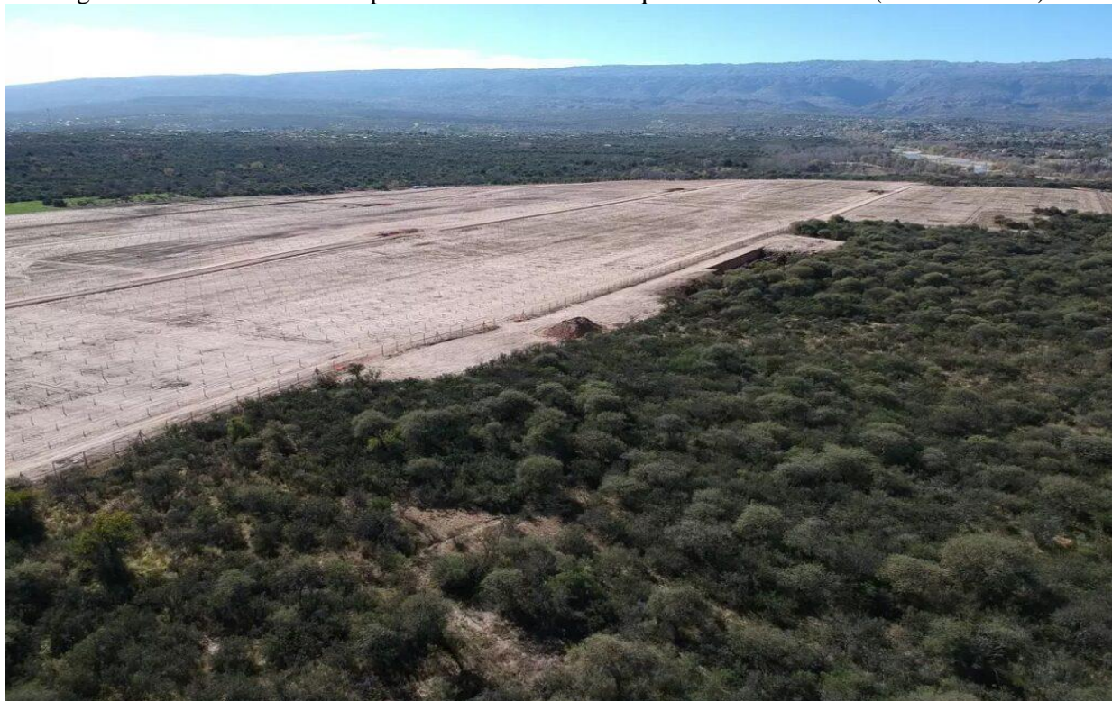
Figura 36 - Área desmontada para el desarrollo del Parque Solar Traslasierra (Cura Brochero)
