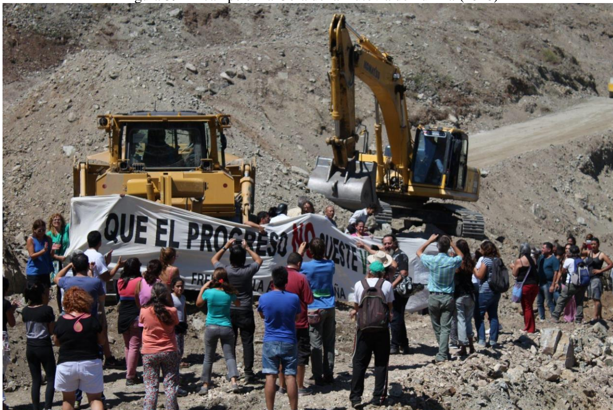
Figura 39 - Acampe en la Obra de la Autovía de Punilla (2018)
