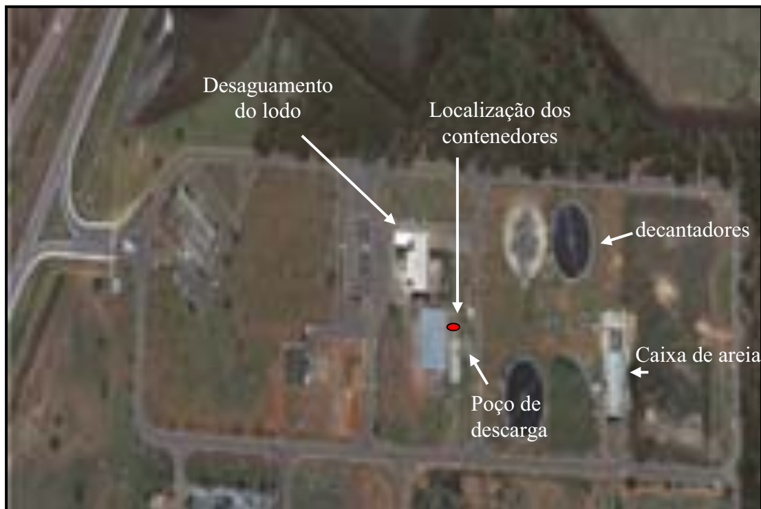
Figura 9 Localização dos contenedores utilizados na pesquisa dentro da Estação de Tratamento de Esgoto de Goiânia.
