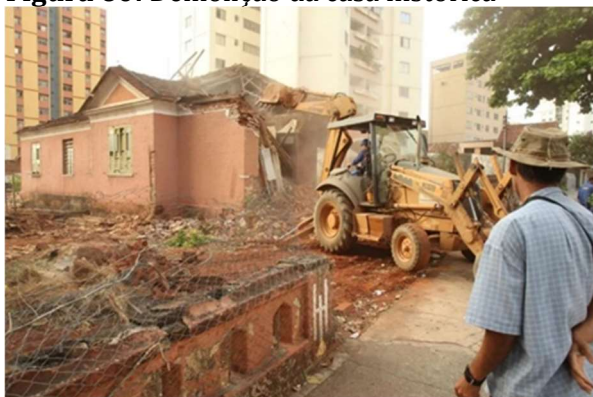
Figura 60: Demolição da casa histórica
