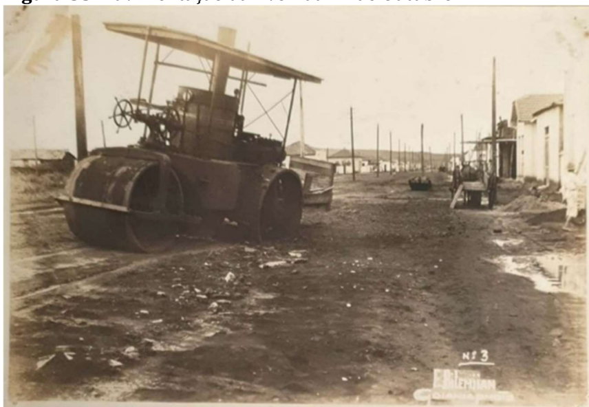
Figura 33: Pavimentação da Avenida 24 de Outubro
