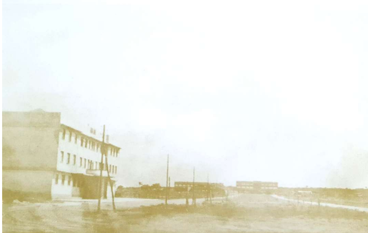
Figura 56: Avenida Goiás e Grande Hotel, em1936
