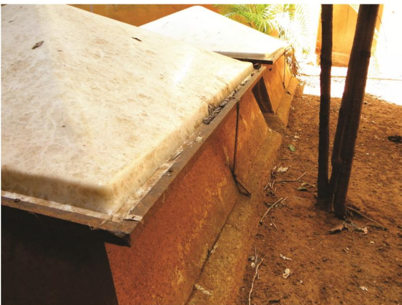
113. Detalhe do domus para exaustão da garagem do edifício sede do IBDF. Fonte: foto do autor deste trabalho. Imagem acervo do Laboratório de Arquitetura e Urbanismo da FAV-UFG.
