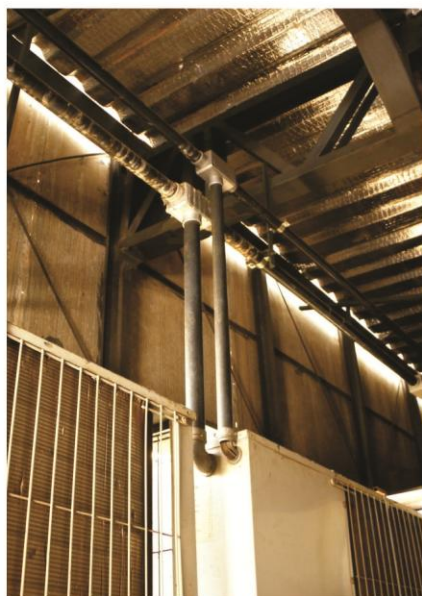
116. Detalhes da parafernália parasitária e incremento programático do edifício sede do IBDF. Fonte: foto do autor deste trabalho.
