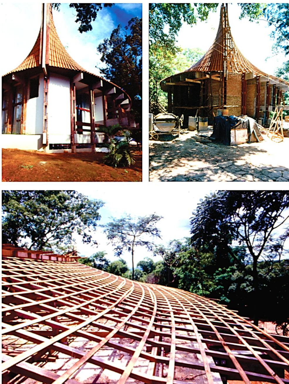
124. O "trecadís" no telhado da Residência Aldi Alves Bezerra.
