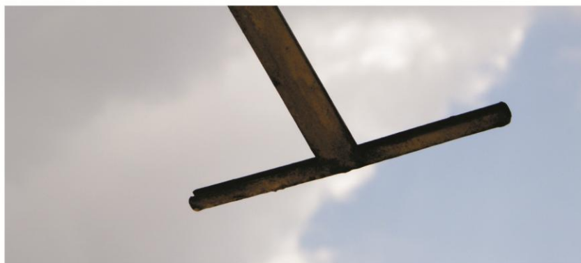
111. Suporte original para a proteção das circulações externas do edifício sede do IBDF. Fonte: foto do autor deste trabalho.
