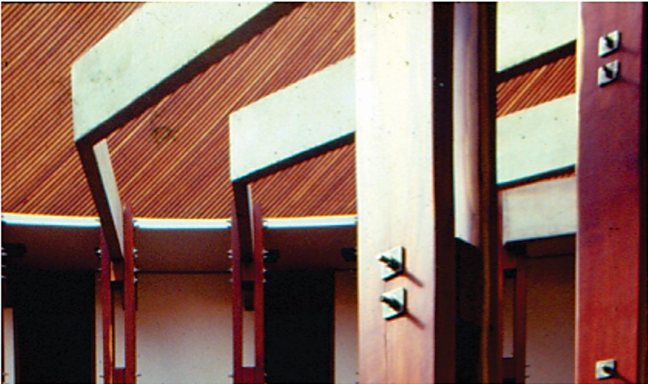
123. A leveza do concreto, sustentado pela madeira na Residência Aldi Alves Bezerra. Fonte: foto do acervo particular do arquiteto Eduardo Simões Barbosa.
