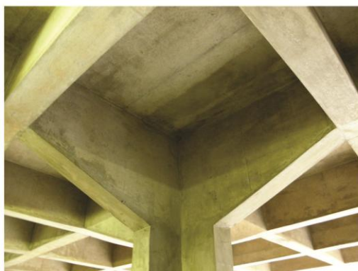
102. Detalhe da mísula do edifício sede do IBDF Fonte: foto do autor deste trabalho. Imagem acervo do Laboratório de Arquitetura e Urbanismo da FAV-UFG.
