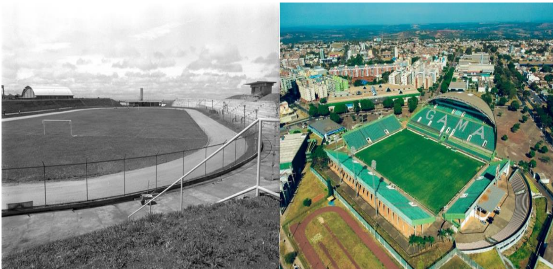
Figura 24 - Estádio Bezerrão antes e depois da reforma.
