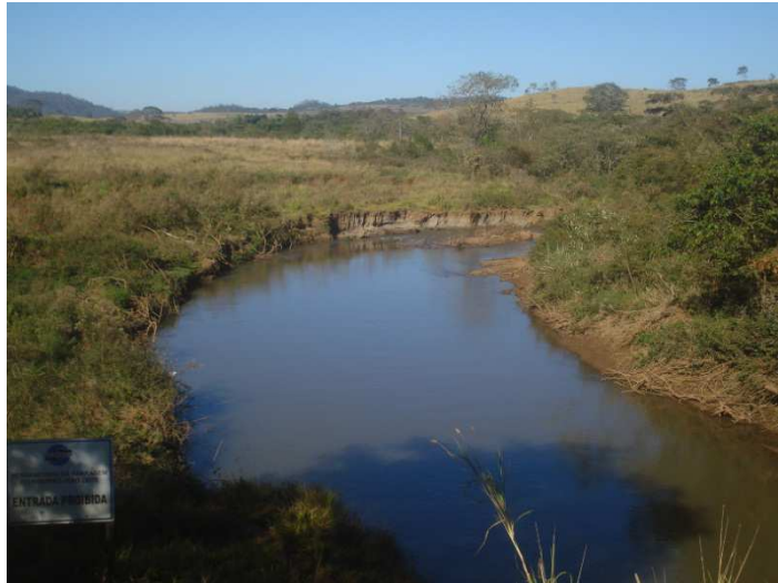
FIGURA 2.15– Ribeirão João Leite a montante da barragem. (julho de 2011).
