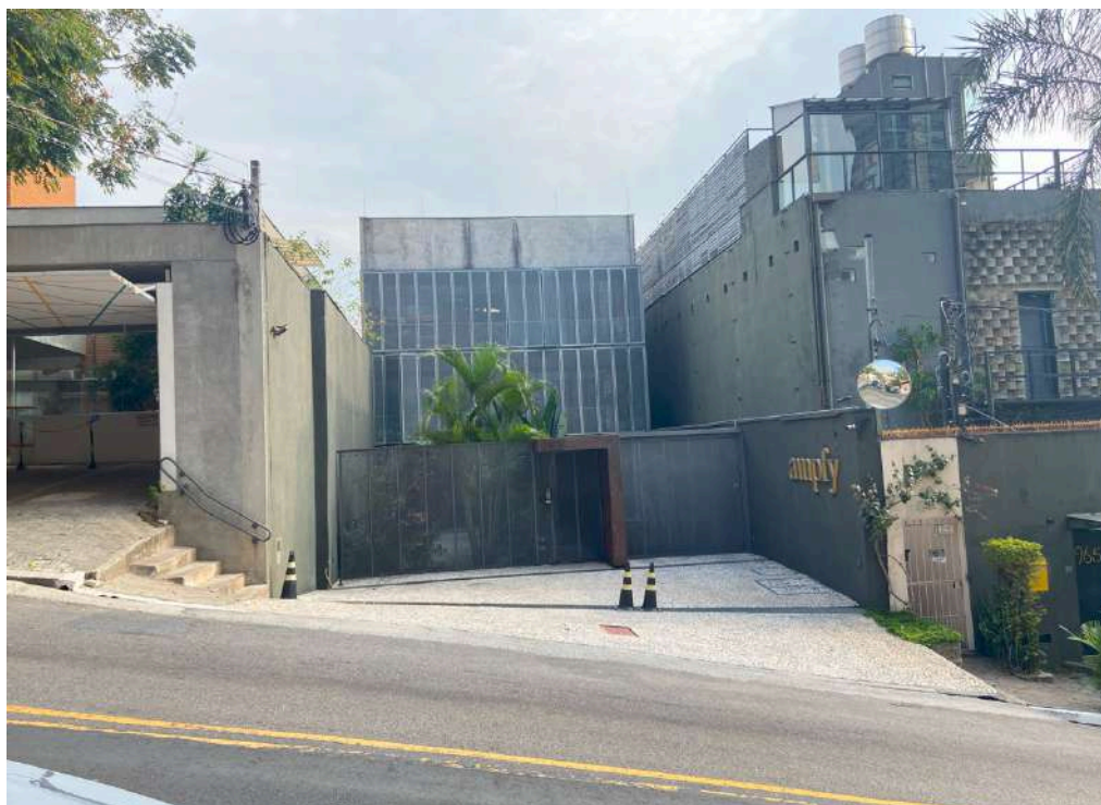
Projeto: RMAA, 2016. Localização: São Paulo, Brasil. O acesso principal é marcado por portões metálicos e fachada translúcida, integrando vegetação na entrada e volumes de diferentes materiais e texturas, em uma composição que equilibra privacidade e permeabilidade visual. Fonte: Acervo pessoal, 2025.
