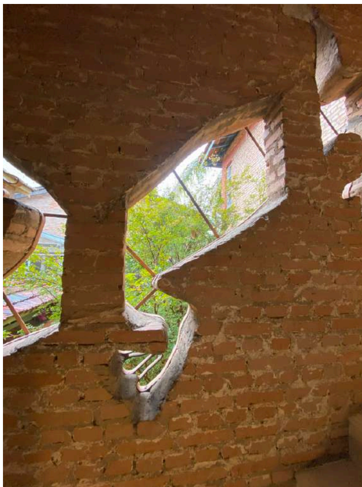
Projeto: Superlimão, 2016. Localização: São Paulo, Brasil. Vista interna destacando elemento de alvenaria aparente com recortes orgânicos, que funcionam como aberturas
