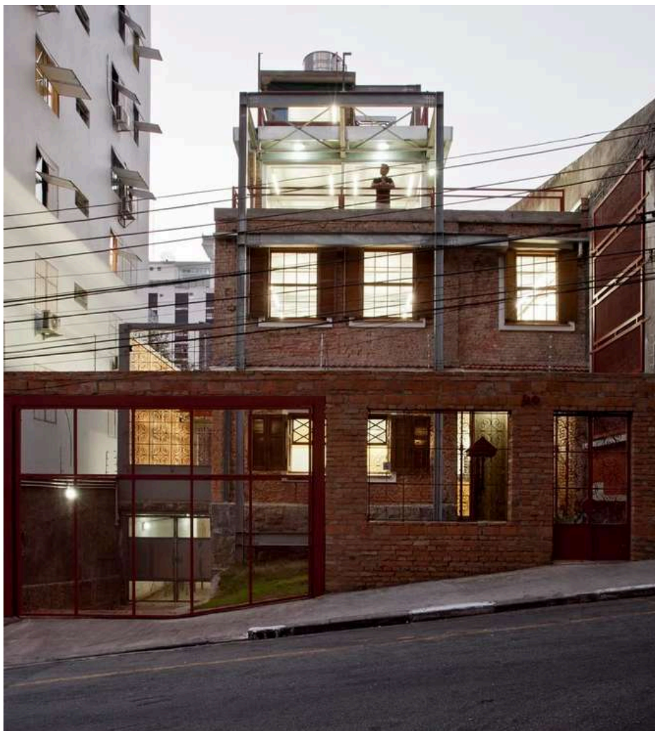
Figura 23. Fachada principal preservando características originais e integrando nova cobertura metálica. Projeto Marília.
