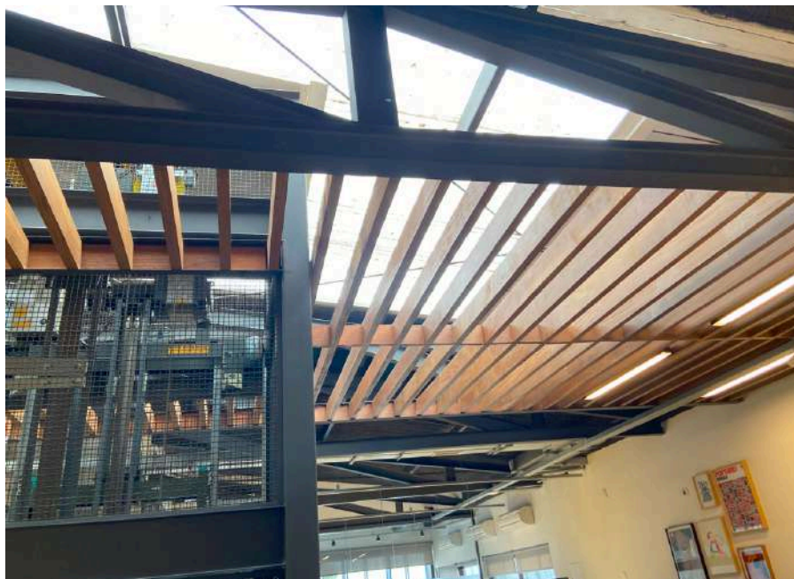
Figura 35. Materialidade — sede da Ampfy.
