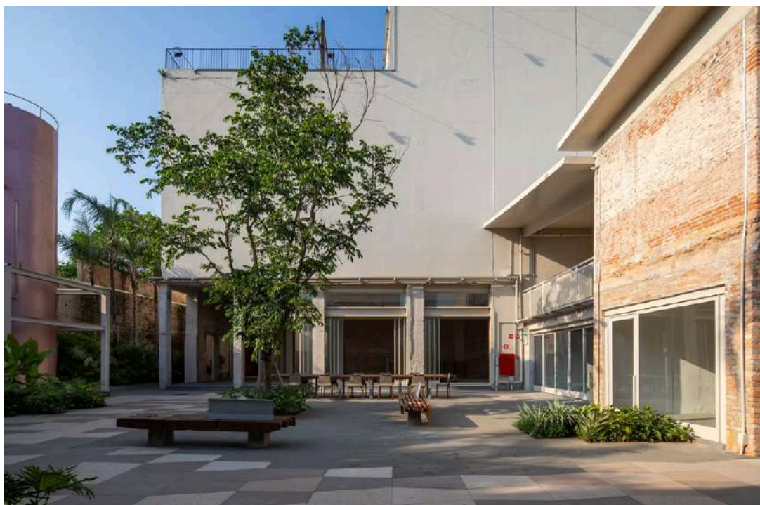
Figura 28. Pátio central do complexo Lapi, integrando retrofit e novas construções.
