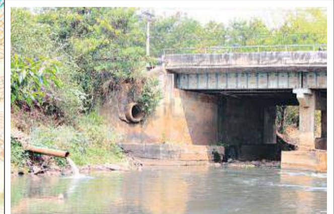
Canos de esgoto despejam dejetos sem qualquer tratamento diretamente dentro do rio. Esse é um dos principais problemas apontados pelos especialistas na região metropolitana.
