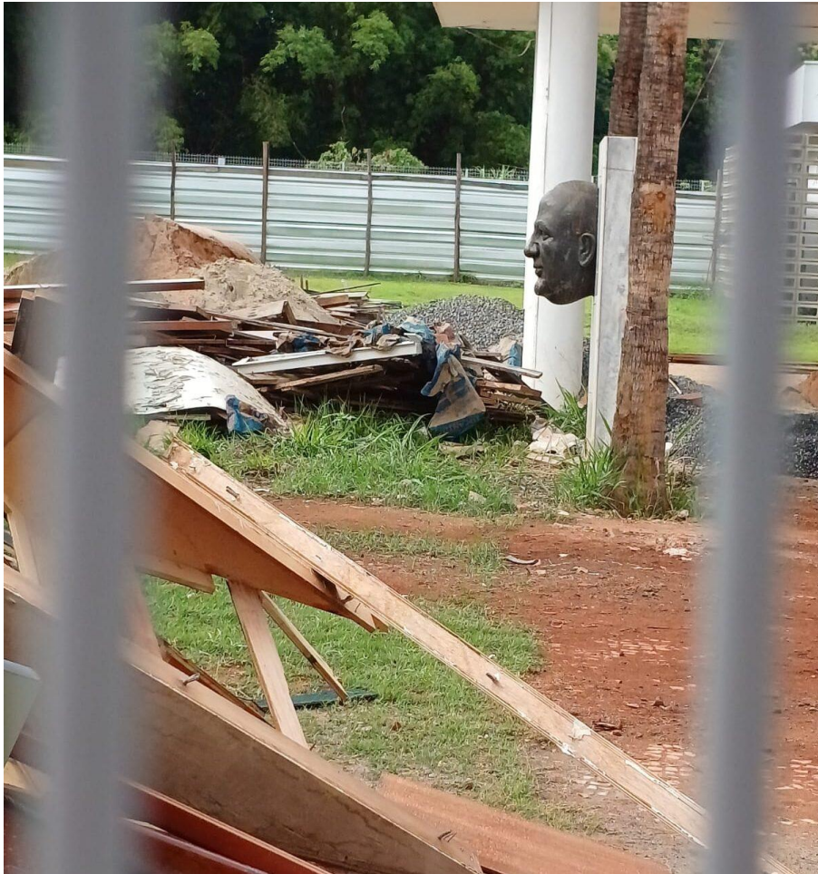
Figura 99– Palácio Alfredo Nasser em obras. Foto: Reprodução TV Anhanguera (2023).
