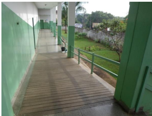
Fig. 10 Corredores de acesso às salas de aulas Escola B
