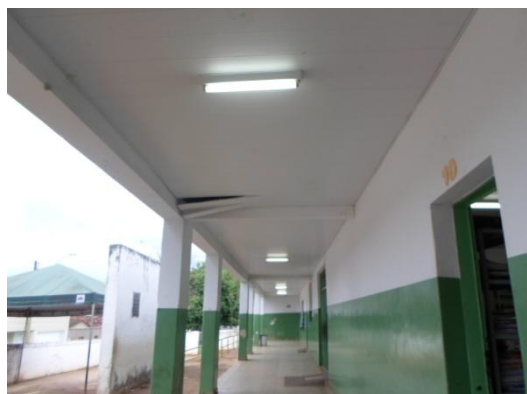
Fig. 13 Entrada e corredor de acesso Escola D
