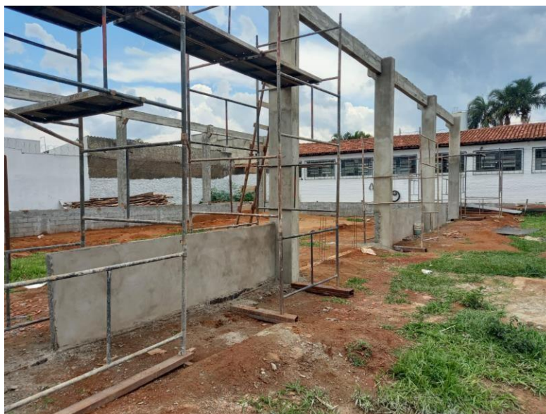
Figura 2: Vista da obra de construção da quadra de esportes
