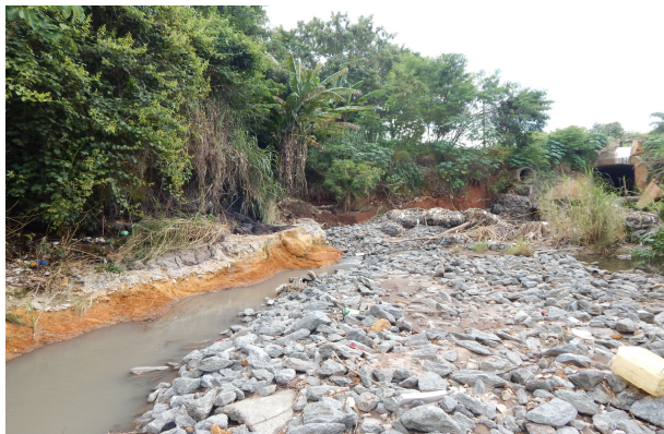
Figura 53 - Entulho. Bacia do Córrego Almeida Fonte: Fotografia de Belizario, W. (2015)
