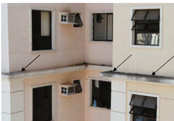
Figura 2.11 – Crescimento de microorganismos em detalhe arquitetônico (fotografado em 2010)
