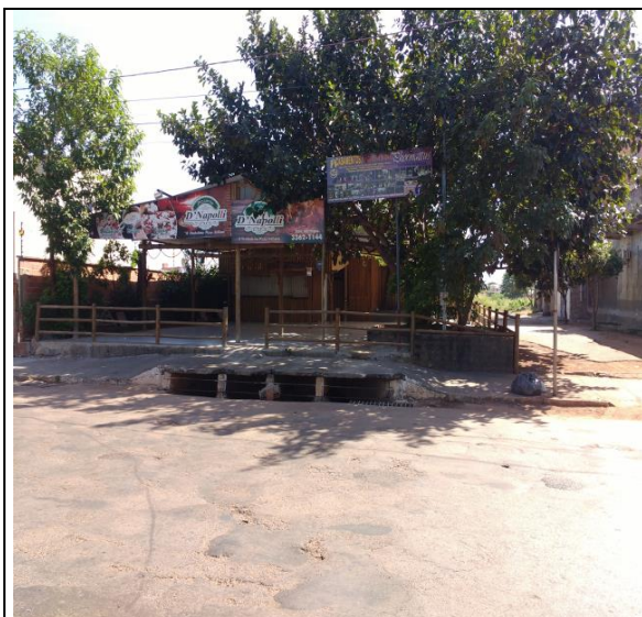
Figura 04: Impermeabilização do solo e, conseqüentemente, a construção de bueiro para escoamento da água. Fonte: BORGES, 2017.
