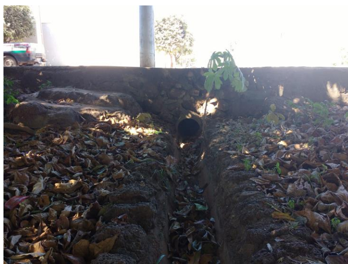
Figura 12 - Canalização de nascentes localizadas nas residências, Porangatu (GO), 2017.
