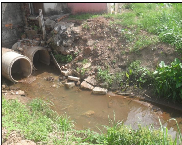
Figura 02: Galeria de escoamento de esgotos lançados diretamente no córrego Barreiro. Fonte: BORGES, 2015.
