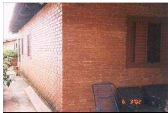
Ilustração 2.12 - Moradia construída em Goiânia/GO - Conjunto Nossa Morada Fonte: Ferreira e Silva. (2003).
