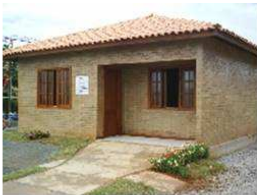
Ilustração 2.11 - Moradia construída em Macaé/RJ Fonte: Emhusa (2006)
