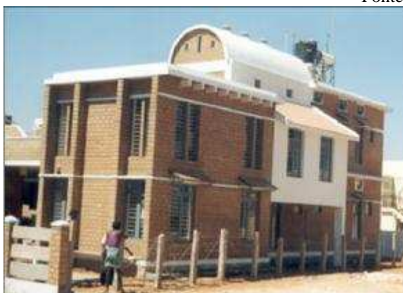
Ilustração 2.8 – Construção com tijolo de solo-cimento em Bangalore - Índia, Fonte: Reddy (2004).
