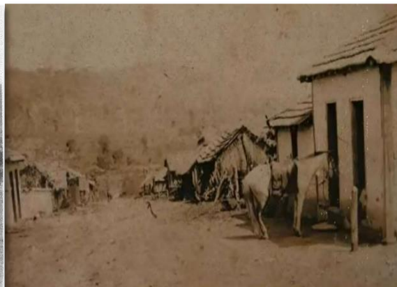
Figura 9 - Primeiras casas construídas ao longo da estrada que foi aberta no interior da fazenda em São Luís de Montes Belos
