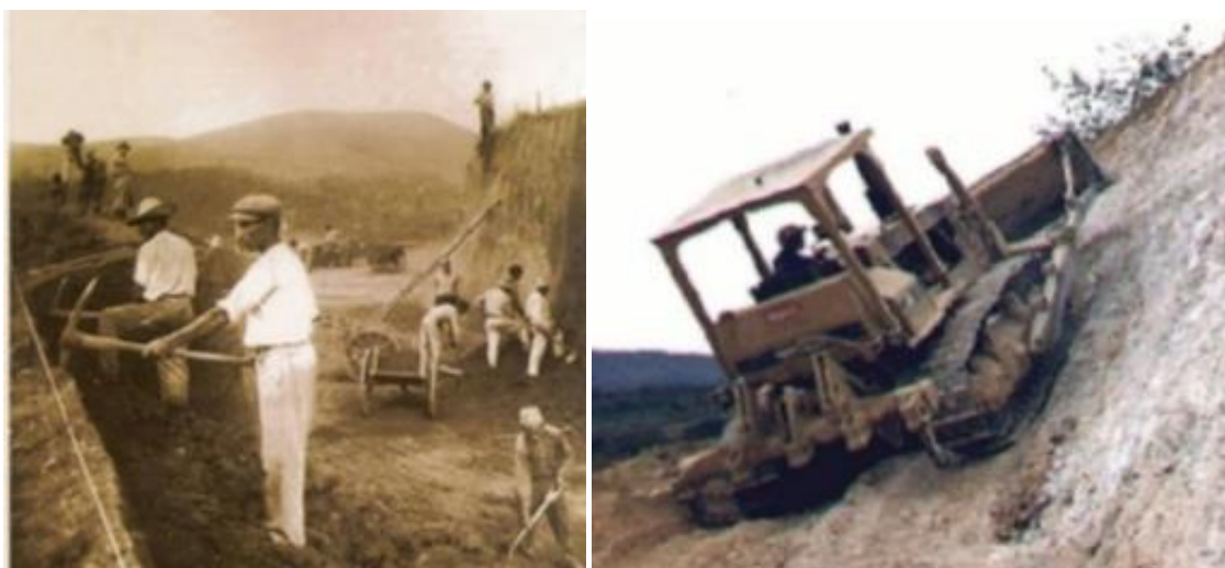
Figura 18 - Pessoas trabalhando na abertura do leito natural das rodovias GO-060 e GO-070, em 1946
