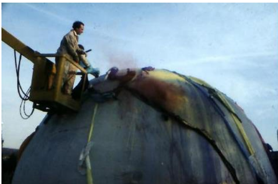
FIGURA 57. Imagem da obra Corpocinema . 186
