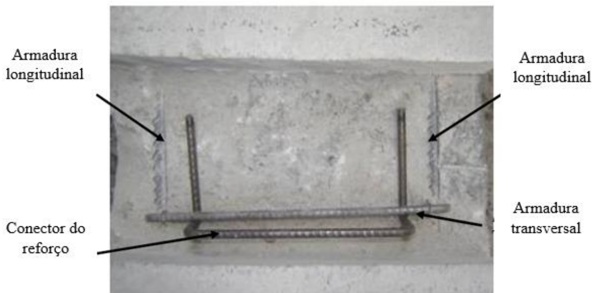
Figura 2. 35- Instalação dos estribos conectores (NASCIMENTO, 2009)
