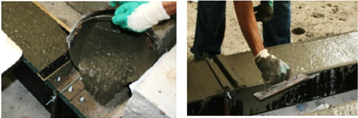
Figura 3. 27 - Lançamento e acabamento da superfície do concreto do reforço
