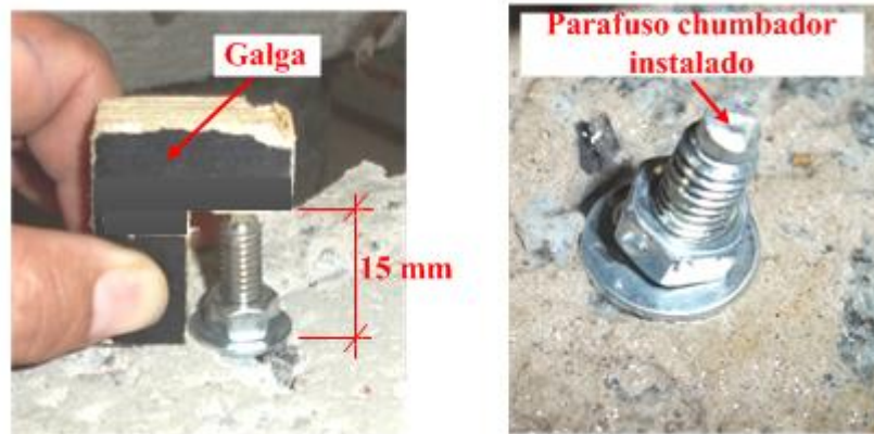
Figura 3. 24 - Detalhe de instalação dos parafusos chumbadores
