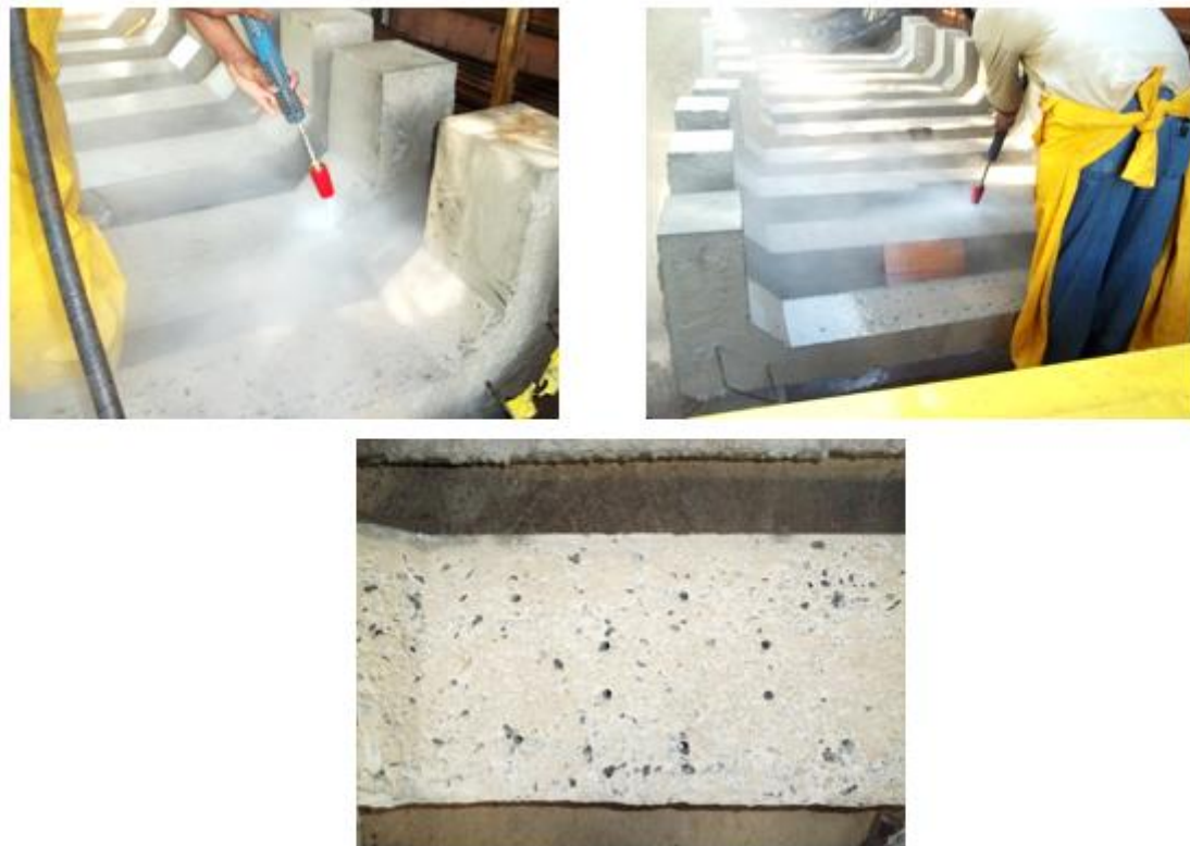
Figura 3. 23 - Escarificação do substrato utilizando hidrodemolidora
