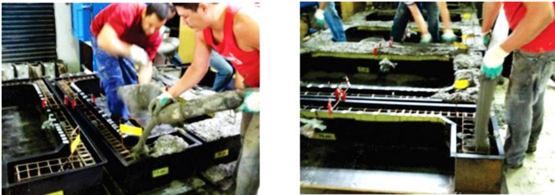
Figura 3. 20 - Lançamento do CAA do substrato dos pilares.
