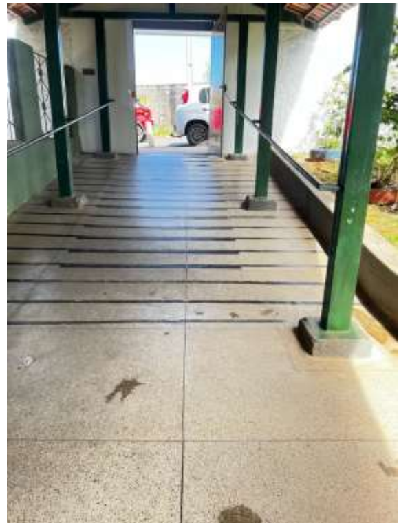
Figura 2 - Vista interna da rampa de acesso da entrada da escola
