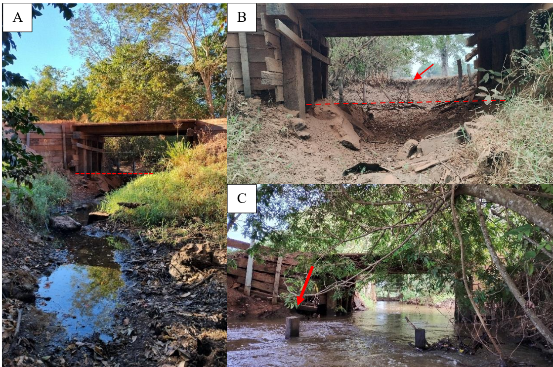
(a) Data 2/12/2023, canal sem fluxo, linha vermelha indica no nível de base. (b) Data 26/10/2024 Canal completamente seco, sem sinal de umidade, seta vermelha indicando “lasca” de cerca como referência de nível 1.40 metros. (c) Data 07/12/2024 Canal com nível pleno, seta vermelha indicando referência de nível, elevação aproximada de 1.15 m. Fonte: O autor.
