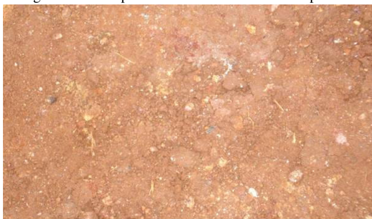
Figura 3.23 – Aspecto da base de cascalho compactada.
