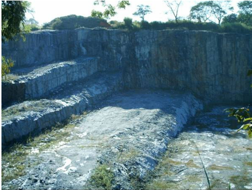
Figura 2.2 – Imagem da jazida de rocha do tipo micaxisto na pedreira do DERMU – COMPAV de Goiânia – desmonte em degraus.
