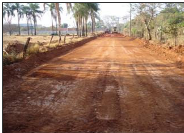
Figura 3.14 – Regularização do subleito do trecho experimental.
