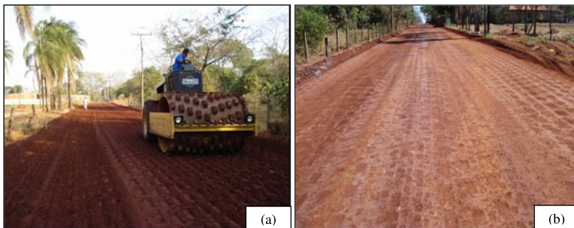
Figura 3.17 - Execução da Sub-base e Base: (a) Compactação da camada com o auxílio de um rolo pé-de-carneiro vibrador; (b) Aspecto da camada após a compactação.
