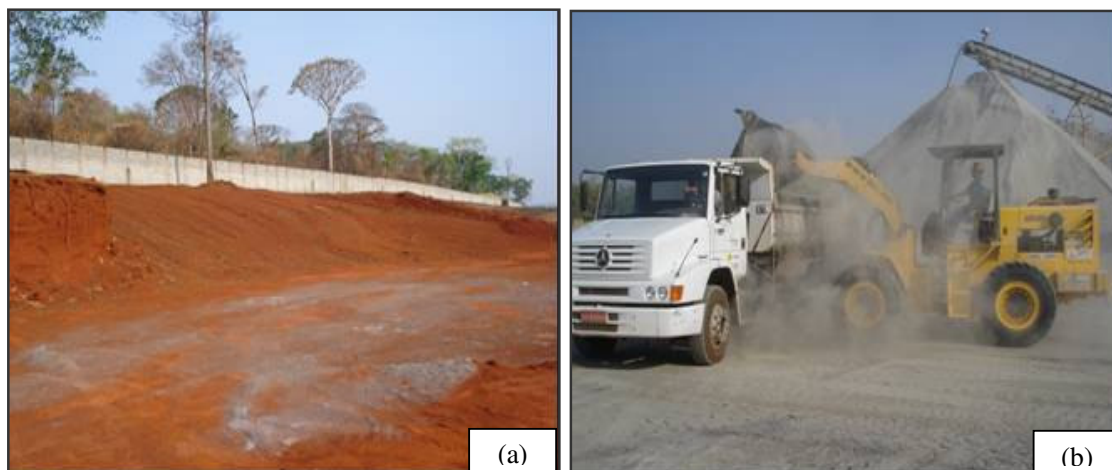
Figura 3.13 – Aquisição de material: (a) Vista da limpeza da área de empréstimo de solo; (b) Coleta do resíduo estudado na pedreira do DERMU-COMPAV.
