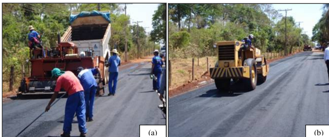
Figura 3.20 – Revestimento: (a) Aplicação de uma camada de três centímetros de revestimento do tipo CBUQ; (b) Compactação da massa asfáltica com rolo de aço liso.
