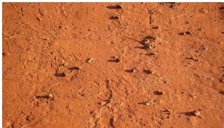
Figura 3.22 – Aspecto da base de solo-brita compactada.
