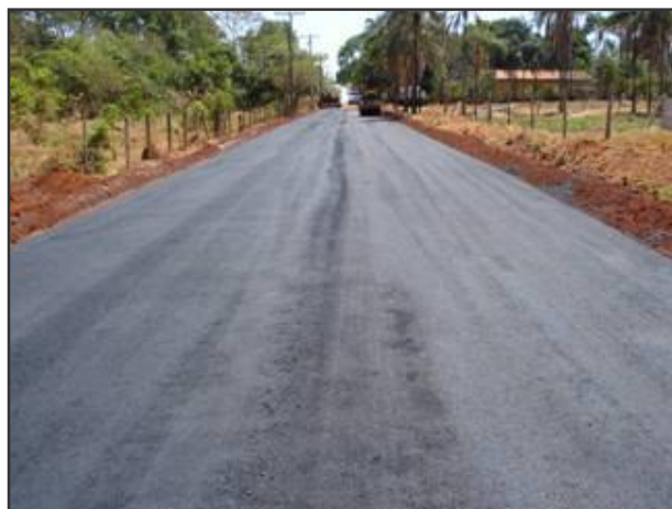
Figura 3. 21 – Vista do trecho após término da sua construção.
