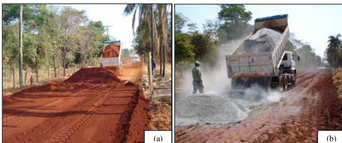
Figura 3.15 – Execução da Sub-base e Base: (a) Recepção e distribuição do solo ao longo do trecho; (b) Repartição das dosagens de 20% e 30%, em peso, do resíduo determinado em cálculo.
