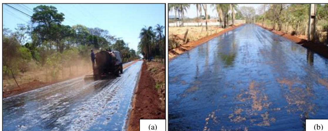
Figura 3.19 – Imprimação: (a) Aplicação de material betuminoso (CM-30) para impermeabilização do trecho; (b) Vista da pista após término da imprimação.
