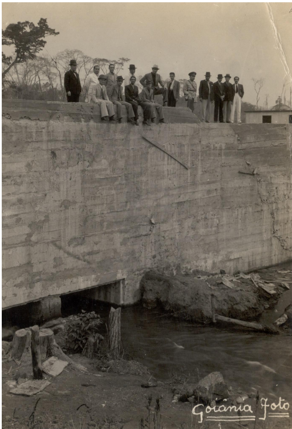
Figura 43 - Barragem da Usina Jaó. 1938. Eduardo Bilemjian. Goiânia – GO. Acervo MIS|GO.
