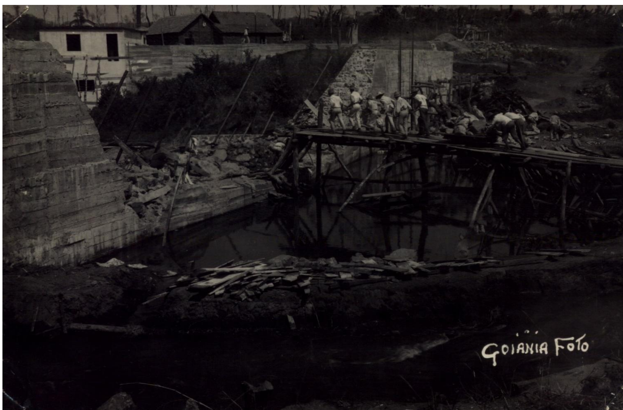
Figura 44 - Construção da Barragem da Usina Jaó, 1939. Eduardo Bilemjian. Goiânia – GO. Acervo MIS|GO.
