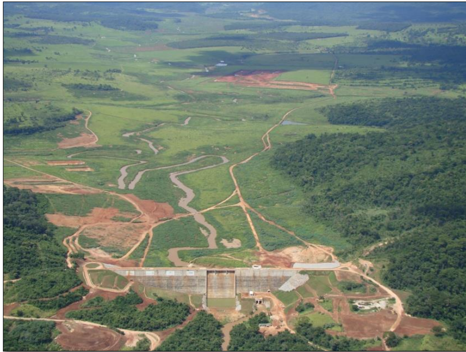
Figura 4 - Construção da barragem concluída e desmatamento em fase final para enchimento do lago Fonte: ASCOM/SANEAGO (Fevereiro de 2013)
