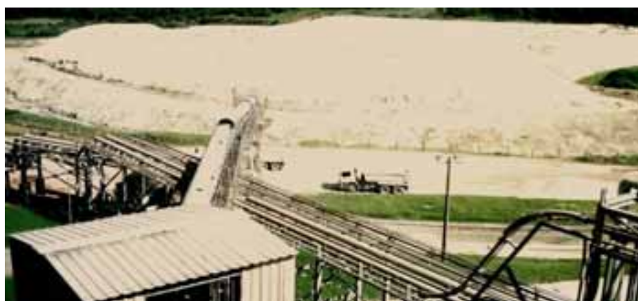
Figura 6.3 – Pátio de disposição final do fosfogesso
