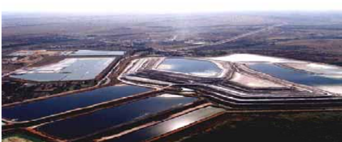
Figura 2.8 – Armazenamento do fosfogesso pelo método “a úmido” (CANUT, 2006).
