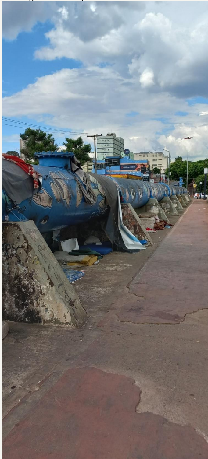
Figura 4 - Instalação hidráulica no centro da cidade
