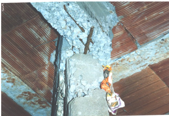
Figura 1.01 – Pilar de imóvel residencial com falhas de concretagem e irregularidades geométricas, executada em Goiânia/1994.(Crea/GO)
