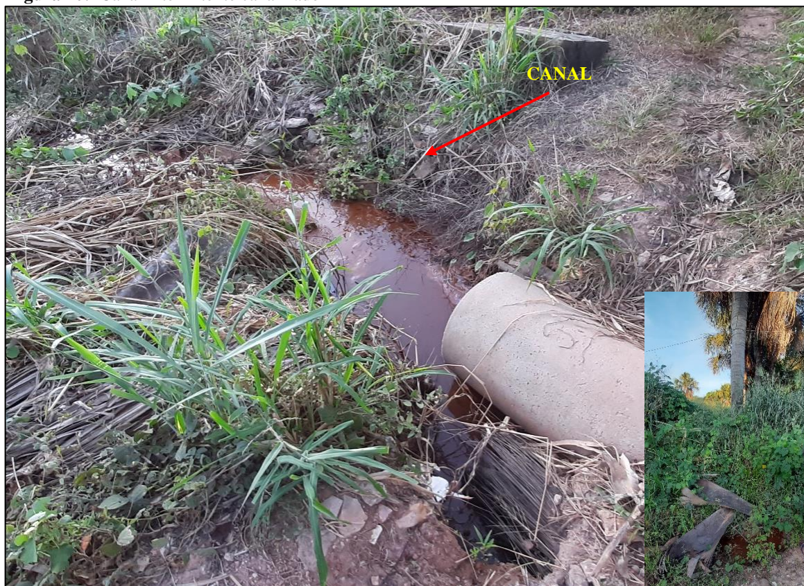
Figura 10: Canal intermitente canalizado
