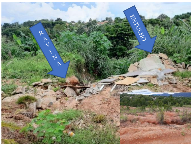
Figura 2: Processo erosivo decorrente da remoção da vegetação nativa
