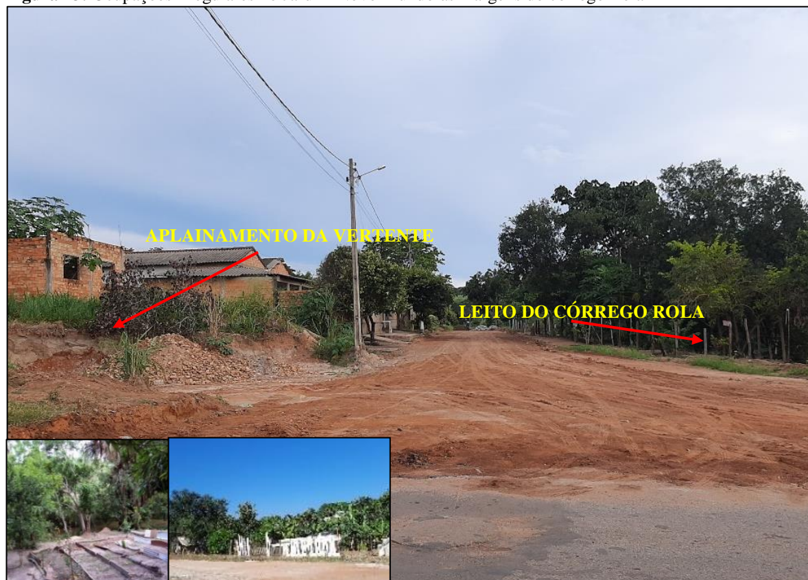
Figura 13: Ocupações irregulares no Jardim Novo Mundo às margens do córrego Rola
