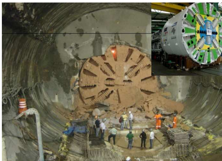
Figura. 2.7 TBM utilizada na Linha Amarela do Metro de São Paulo em 2009.
