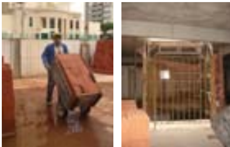
Figura 4.53: Transporte vertical e horizontal na obra, empresa D.
