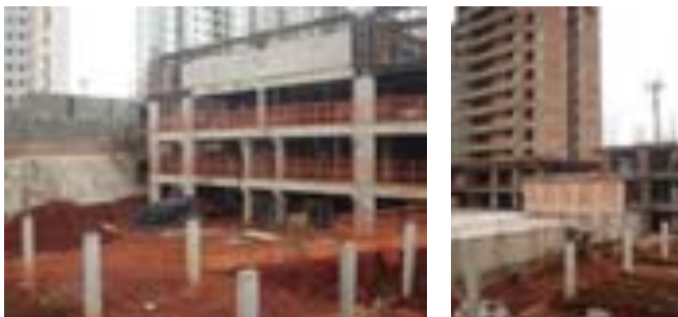
Figura 4.34: Canteiro de obras da empresa F
