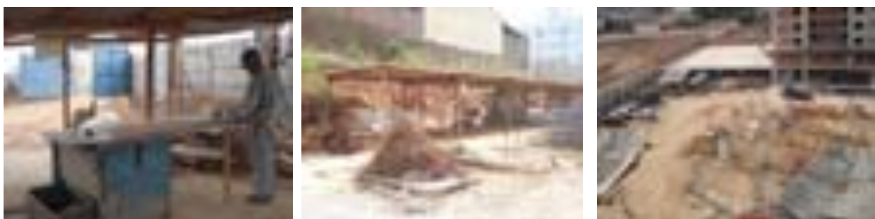
Figura 4.2: Segurança no trabalho e organização do canteiro, empresa A
