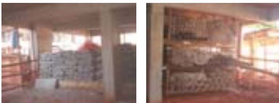
Figura 4.9: Armazenamento de materiais no canteiro de obras, empresa B
