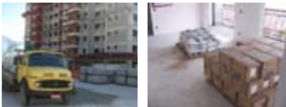
Figura 4.46: Recebimento e armazenagem dos materiais, empresa H
