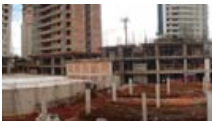
Figura 4.34: Vista geral do canteiro, construção das duas torres, etapas diferenciadas, empresa F
