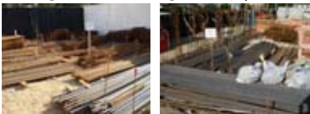
Figura 4.47: Ferragem armazenada no canteiro, empresa H
