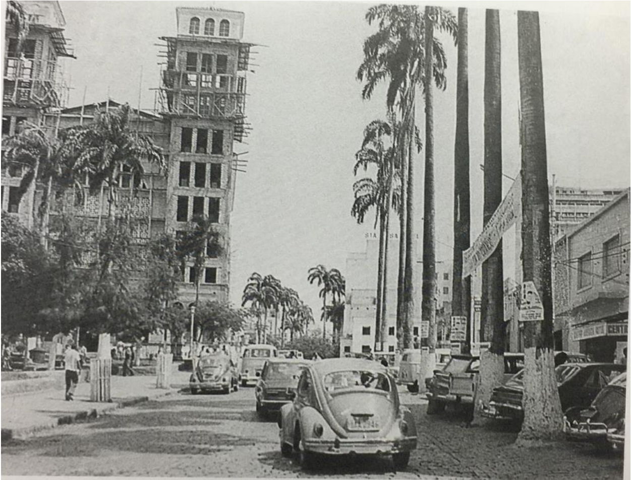
Figura 3 – Fachada da nova Matriz, ainda em obras, a partir da Av. Getúlio Vargas no início da década de 1970.
