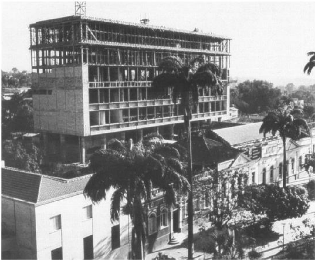
Figura 10 – No primeiro plano, o conjunto antigo, onde situava o velho Palácio Alencastro, ao fundo, o novo em construção em meados de 1960.
