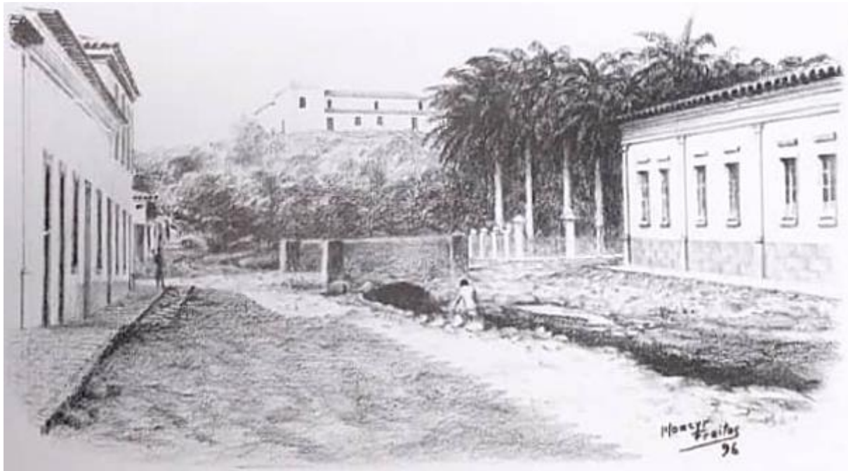
Figura 40 – Ilustração da ponte de pedra sobre o Córrego Cruz das Almas, no cruzamento da Generoso Ponce com a Rua 13 de Junho, na década de 1910. Na direita, ao fundo, visualiza-se as palmeiras imperiais da Praça Ipiranga.
