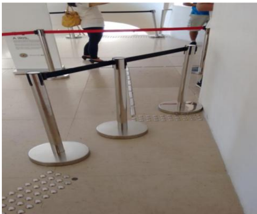
Figura 51 - Barreira obstruindo a passagem do usuário do piso podó tátil
