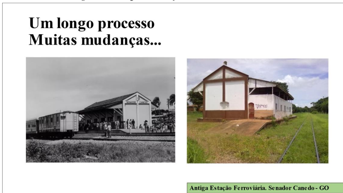
Figura 15 – Imagens da Estação ferroviária de Senador Canedo
