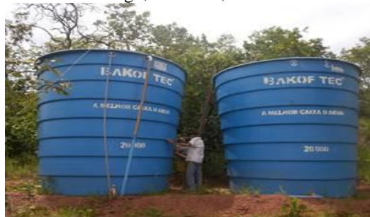
Figura 16. Reservatórios de acumulação da água do poço artesiano instalado nos assentamentos da região Pinga-Fogo, Mineiros, Goiás.
