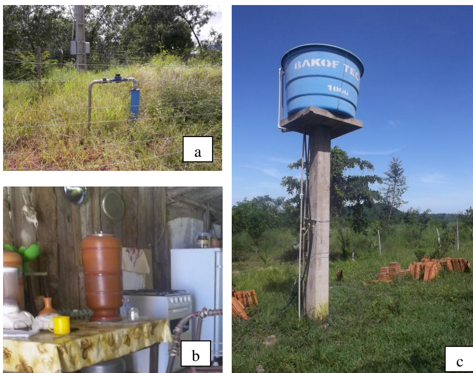
Figura 39. a) Poço artesiano; b) filtro de barro e c) reservatório elevada.
