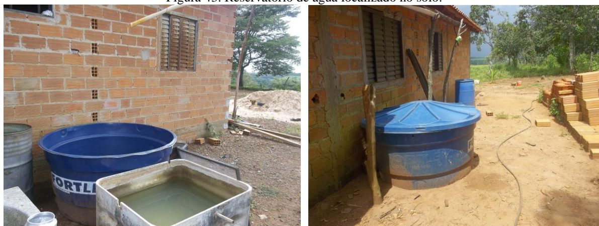
Figura 43. Reservatório de água localizado no solo.
