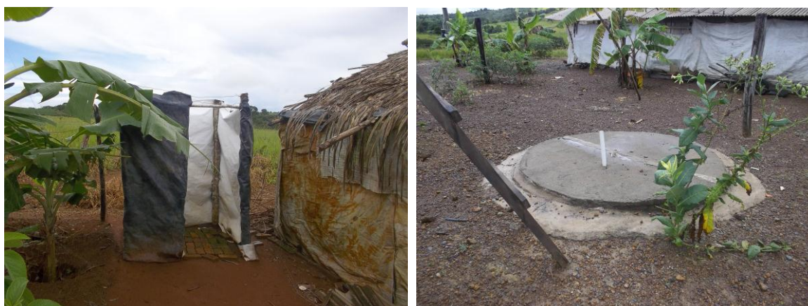
Figura 49. a) Privada de fossa seca e b) fossa rudimentar utilizada para o destino das águas negras.
