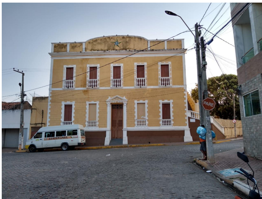
Foto 11 – Antigo Prédio de Câmara e Cadeia – atual Escola de Saberes, município de Barbalha. Autora: COSTA, Ana Paula Rodrigues, 2019.
