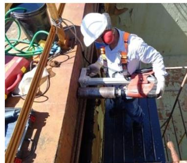
Figura 3.11 – Extração do testemunho
