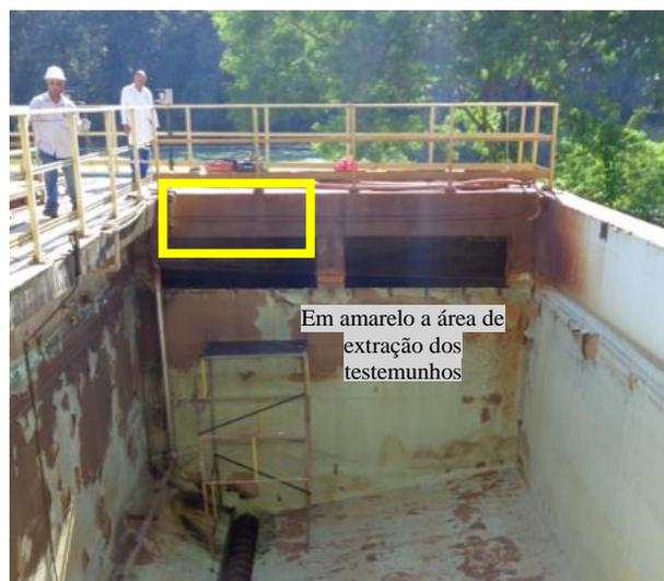
As Figura 3.9 a Figura 3.12 ilustram de forma sequencial do procedimento adotado para extração dos testemunhos.
