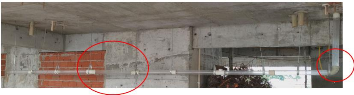
Figura 3.21 – Instalação de dois desvios de 45° cada com a utilização de um joelho de 45° em cada desvio. 2J45.
