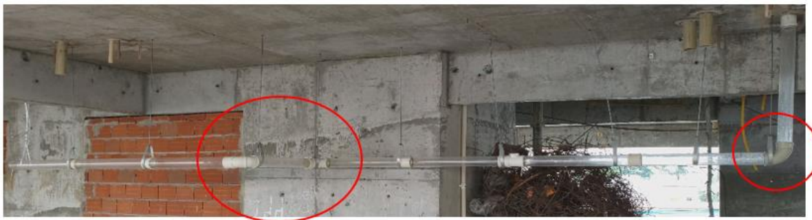
Figura 3.19 - Instalação com dois desvios horizontais de 90° cada com dois joelhos de 45° cada. 4J45.
