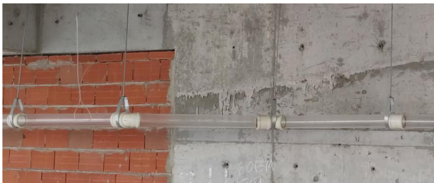
Figura 3.21 – Instalação de dois desvios de 45° cada com a utilização de um joelho de 45° em cada desvio. 2J45.
