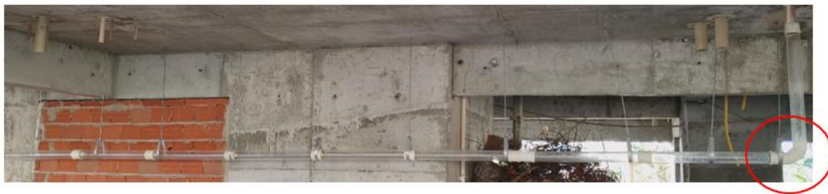
Figura 3.11- Instalação de dois joelhos de 45°. J45-L.
