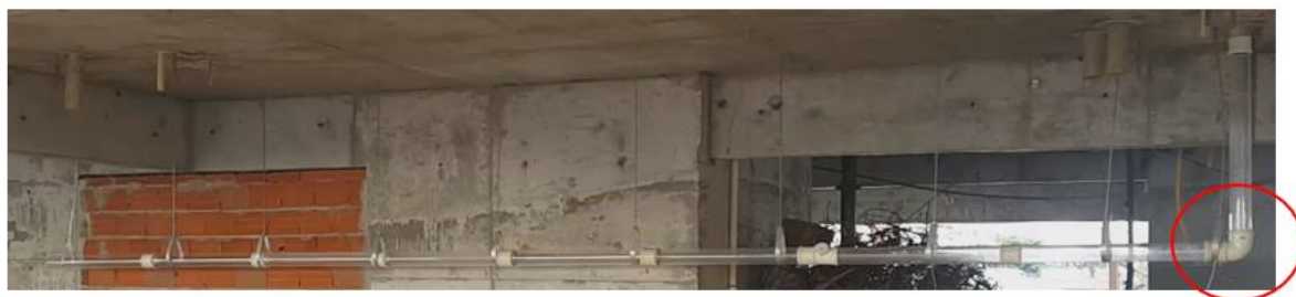
Figura 3.9- Instalação de joelho de 90°. J90-L.
