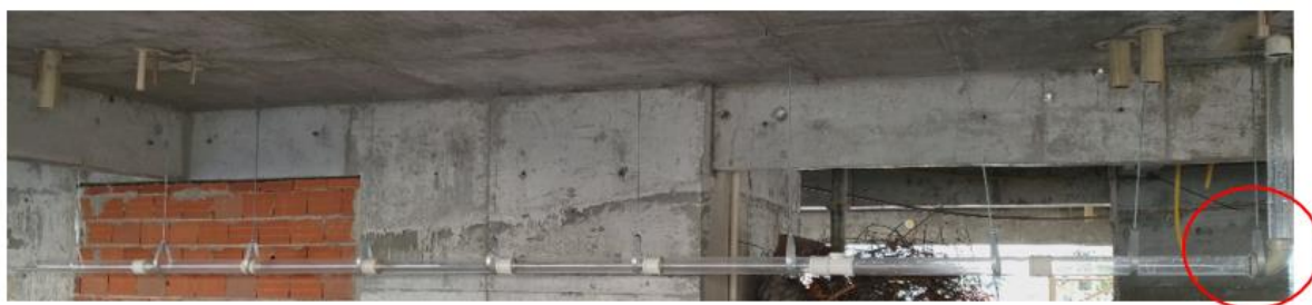
Figura 3.13 - Instalação de curva 87°30". C87.
