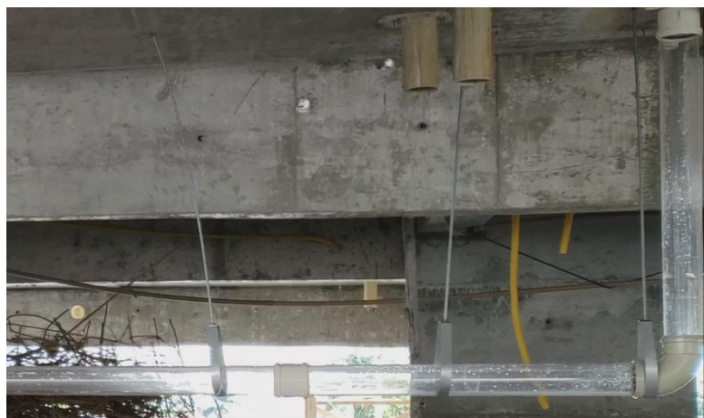
Figura 3.13 - Instalação de curva 87°30". C87.
