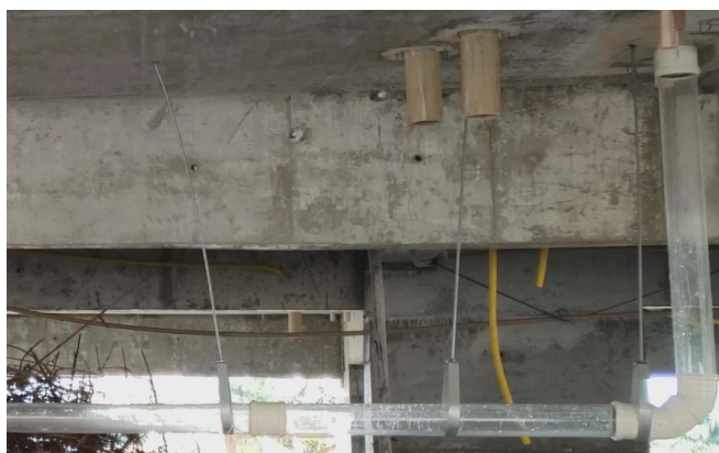
Figura 3.12- Configuração Linear (L) do sub-coletor com a utilização de curva 87°30". C87-L.
