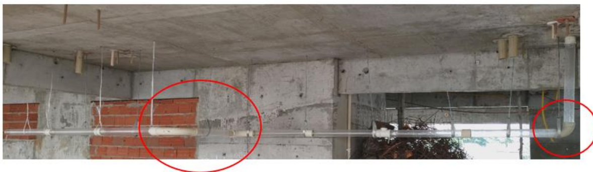
Figura 3.17 - Instalação do desvio horizontal com duas curvas curtas de 90°. 2C90L.
