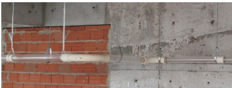
Figura 3.17 - Instalação do desvio horizontal com duas curvas curtas de 90°. 2C90L.
