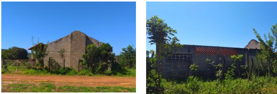
Figura 6: Antigo armazém de beneficiamento de arroz construído pelo INCRA
