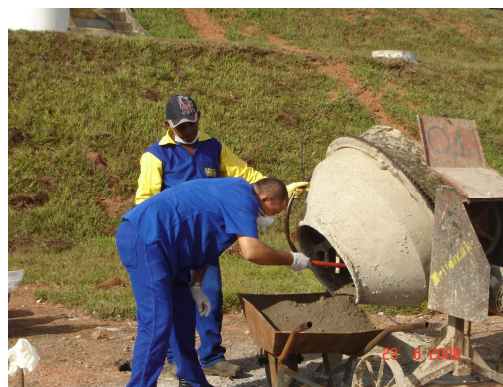
Figura 4.4.3 Retirada do lodo caleado da betoneira
