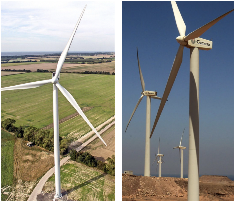
Figura 1.2 – Turbinas eólicas de eixo horizontal.
