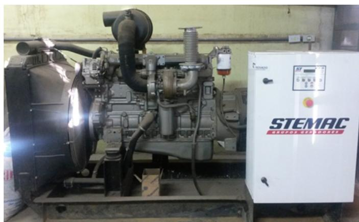
Figura 5.1 - Conjunto moto-gerador a diesel.
