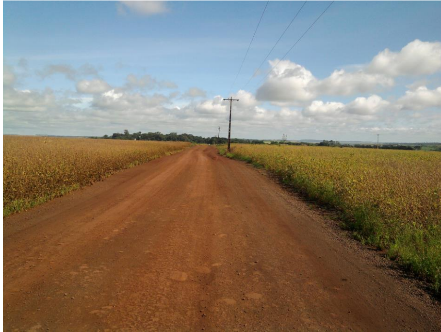
Fig. 04 Estrada Rural Potrerito
